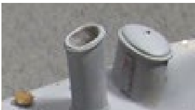
wydrążony i uzupełniony komin
